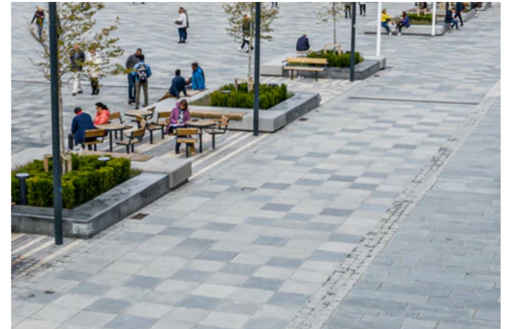
GRANITMURAR RUNT PLANTERINGAR MED SITTPLATSER PÅ ETT GOLV AV GRANITSTEN PHOTO VESTRE ©
