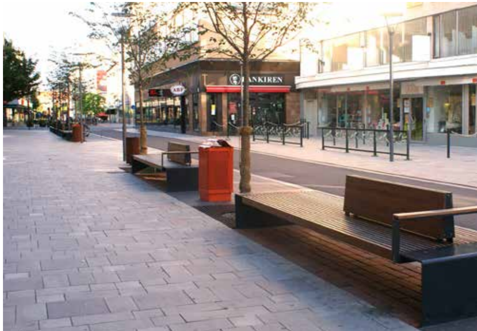
GATA KNYTS SAMMAN AV STENLÄGGNING MED SMAL ASFALTSYTA FÖR ENKELRIKTAD FORDONSTRAFIK PHOTO NOLA ©
